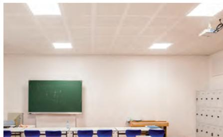
*Der erhöhte Lichtreflexionsgrad (-70%) sorgt für eine gleichmäßigere Lichtverteilung im sanierten Klassenraum. Zusätzlich wird die Schadstoffbelastung der Raumluft durch Activ'Air erheblich reduziert.*
